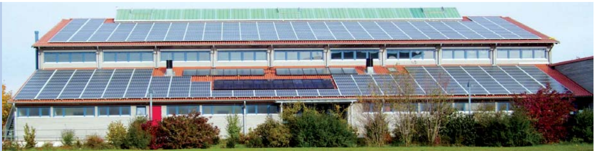
Photovoltaikanlage auf dem Dach der Sporthalle in Haßloch
