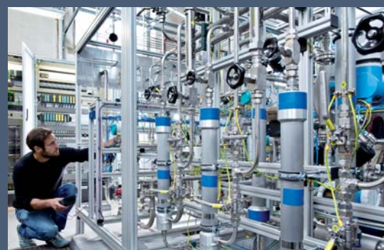
Eine Power-to-Gas-Forschungsanlage mit 250 Kilowatt elektrischer Eingangsleistung am Zentrum für Sonnenenergie- und Wasserstoff-Forschung Baden-Württemberg (ZSW)
