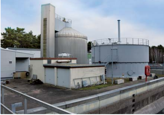
Kläranlage Haßloch gebaut 1983, modernisiert 1999.
