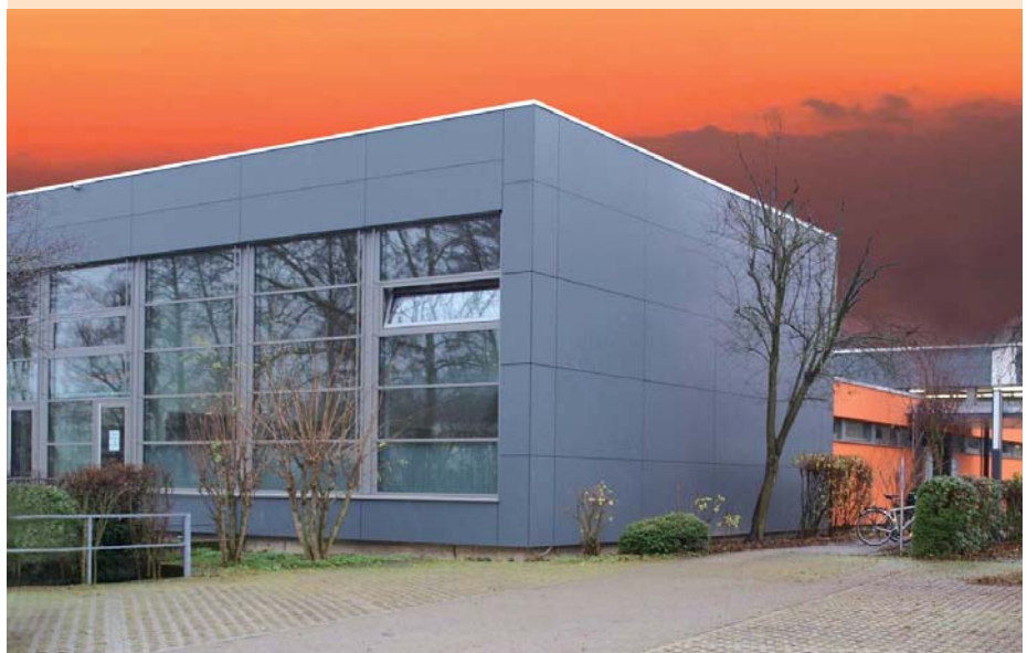
Hallenbad von außen: Die Fassade wurde ebenfalls erneuert, ebenso wie die Glasfront und das Dach
