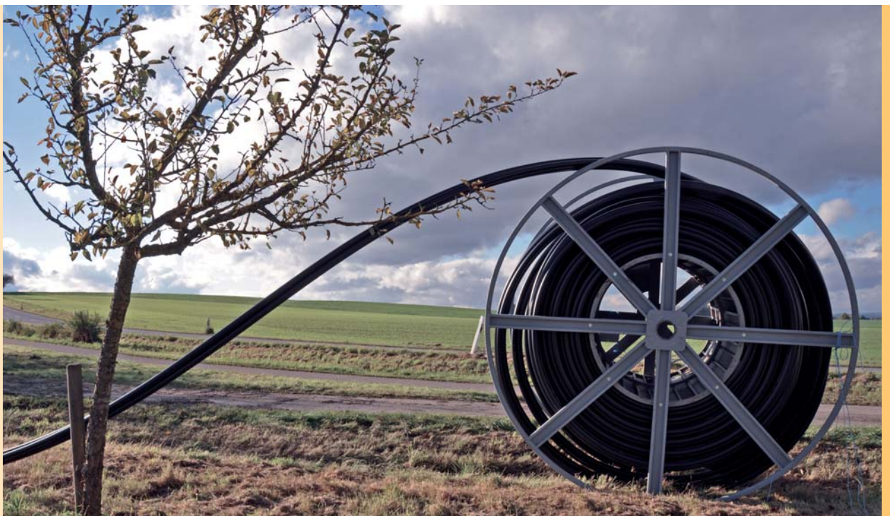
40 Kilometer neue Kabel für mehr Qualität bei Netzsicherheit, Netzwartung und Netzstruktur
