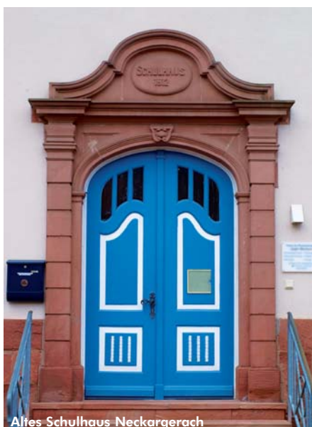
Altes Schulhaus Neckargerach
